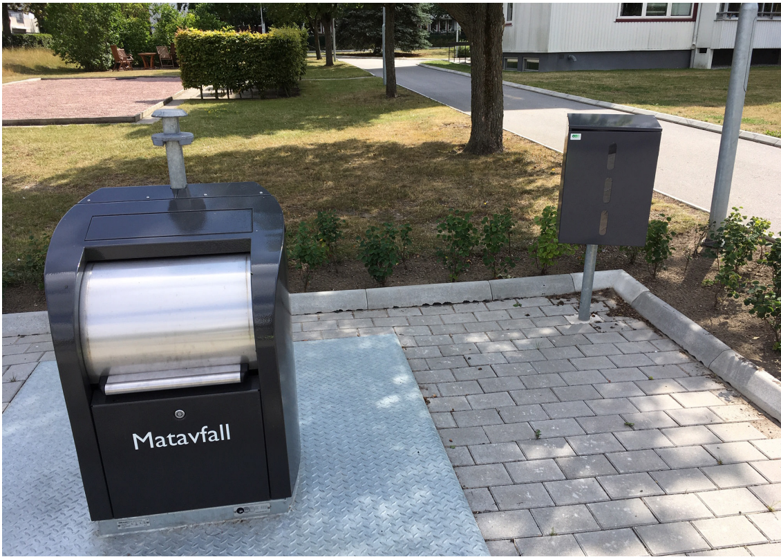
UWS kompletterat med ett skåp för matavfallspåsar
